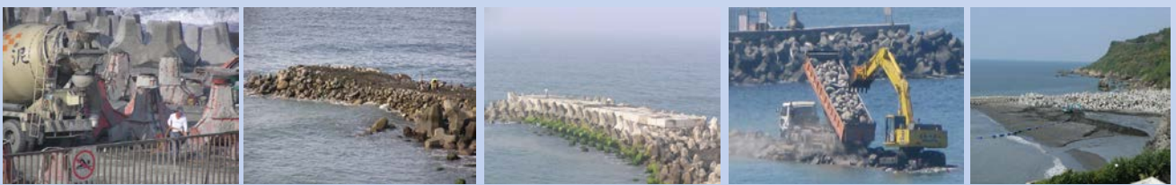
圖4 西子灣海灘復育的人工岬頭施工及養灘過程(民國95~97年)
