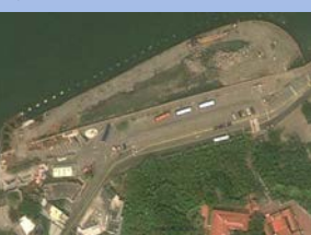
圖11 填海造陸施工過程(民國99年10月)
